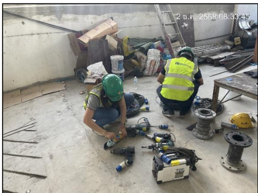
ภาพที่ 44 กิจกรรมตรวจสอบอุปกรณ์ไฟฟ้า
